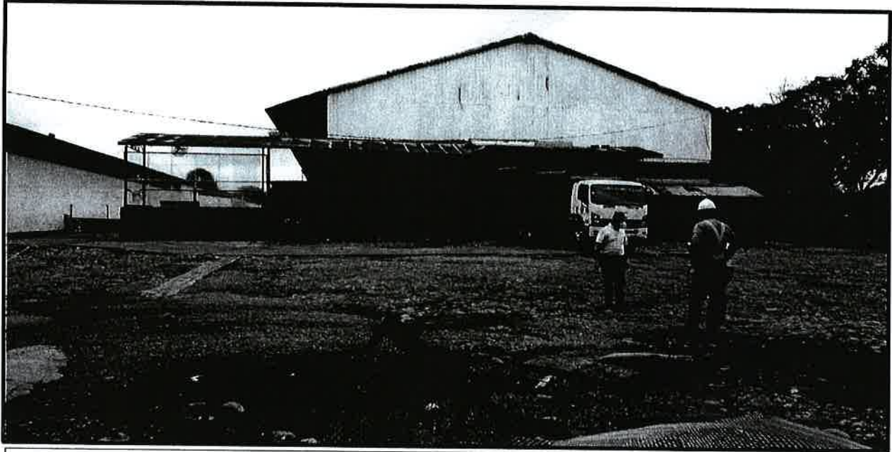
Figura 2- Vista del área del proyecto donde se van a construcción y mejoras a las galeras del proyecto NUEVA PLANTA DE ALIMENTOS BALANCEADOS DE LA COOPERATIVA DE SERVICIOS MÚLTIPLES DE PRODUCTORES DE LECHE DE PANAMA, R.L., (COOLECHE, R.L.) octubre 2020.
