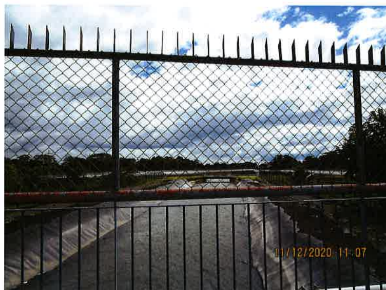
Foto 13. Hidroeléctrica colindante al polígono del proyecto.
