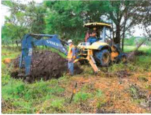
Foto 5. Vista de excavaciones de estudio de suelo.
