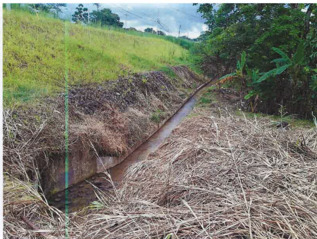
Foto 4. Vista de Canal concreto rectangular b=1.25\text{ m} h=0.35\text{ m} en parte frontal del terreno
