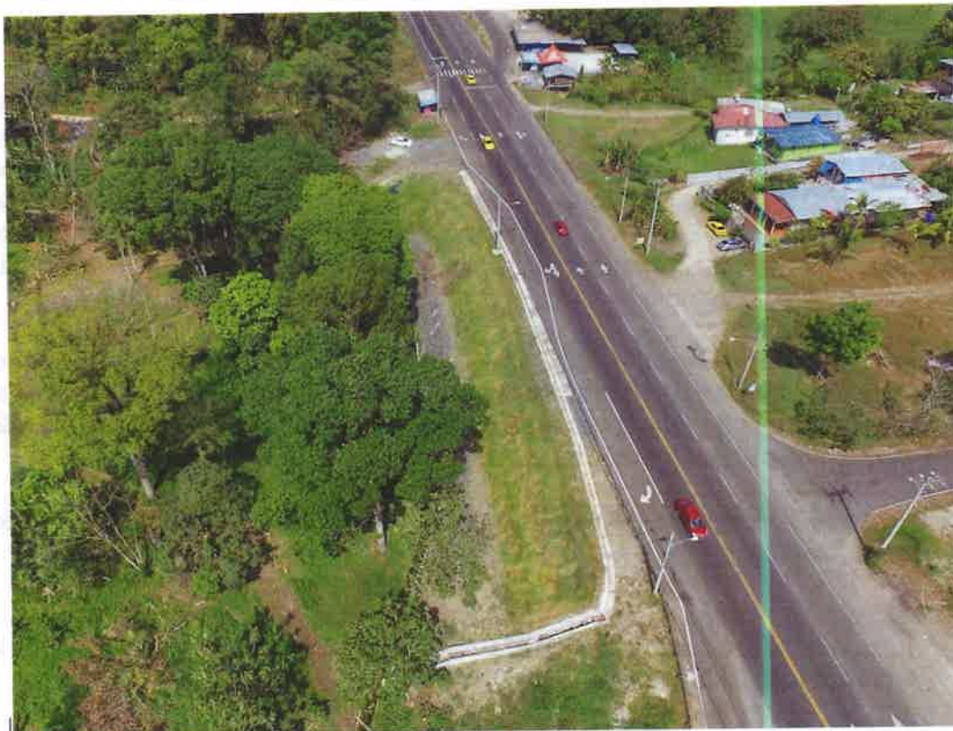
Foto 5. Vista de Cuneta trapezoidal base 0.30 m de pista y bajante hidráulica.
