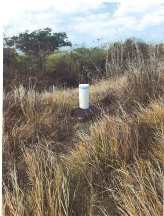
Imagen # 2 Pozo No1. Perforado y sellado
