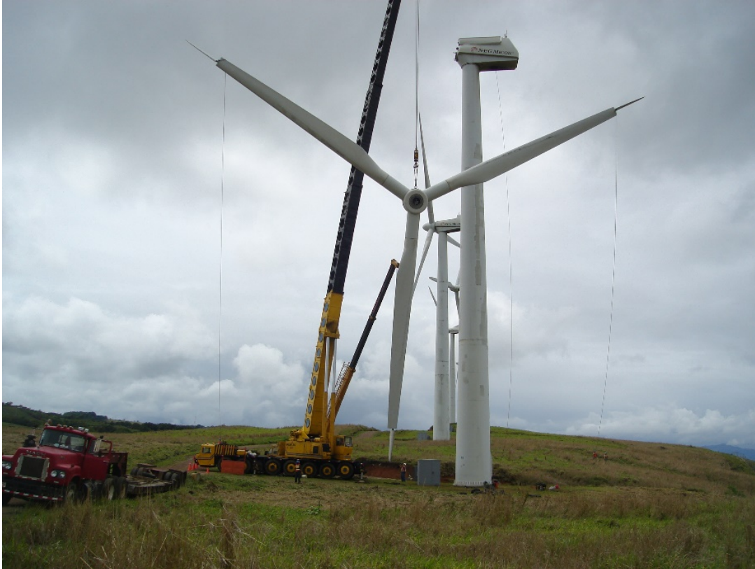
Figura 5-11: instalación de rotor.
