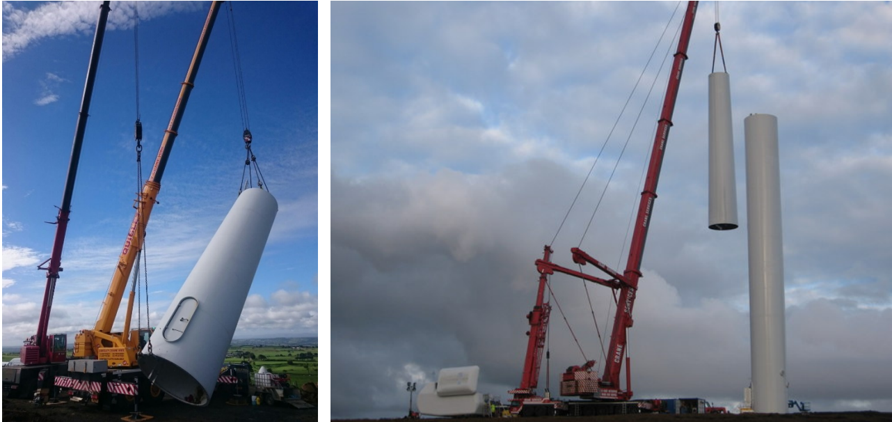
Figura 5-10: Proceso de montaje de torres.
