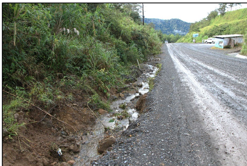
Fotografía 11. Drenajes deficientes en el área de Cerro Hornito.
