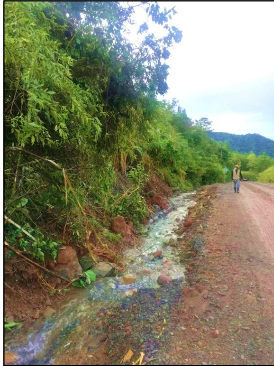
Fotografía 24. Drenajes ineficientes al margen de carretera
