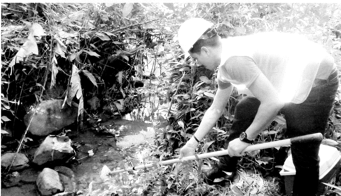
Toma de agua, Quebrada sin nombre.
