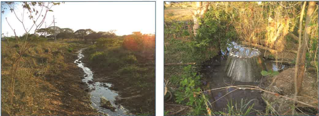
Imágenes: La imagen de la izquierda muestra el drenaje principal, al que han llamado “quebrada”. A la derecha se muestra el registro dañado del IDAAN que libera aguas negras dentro de nuestra finca.
