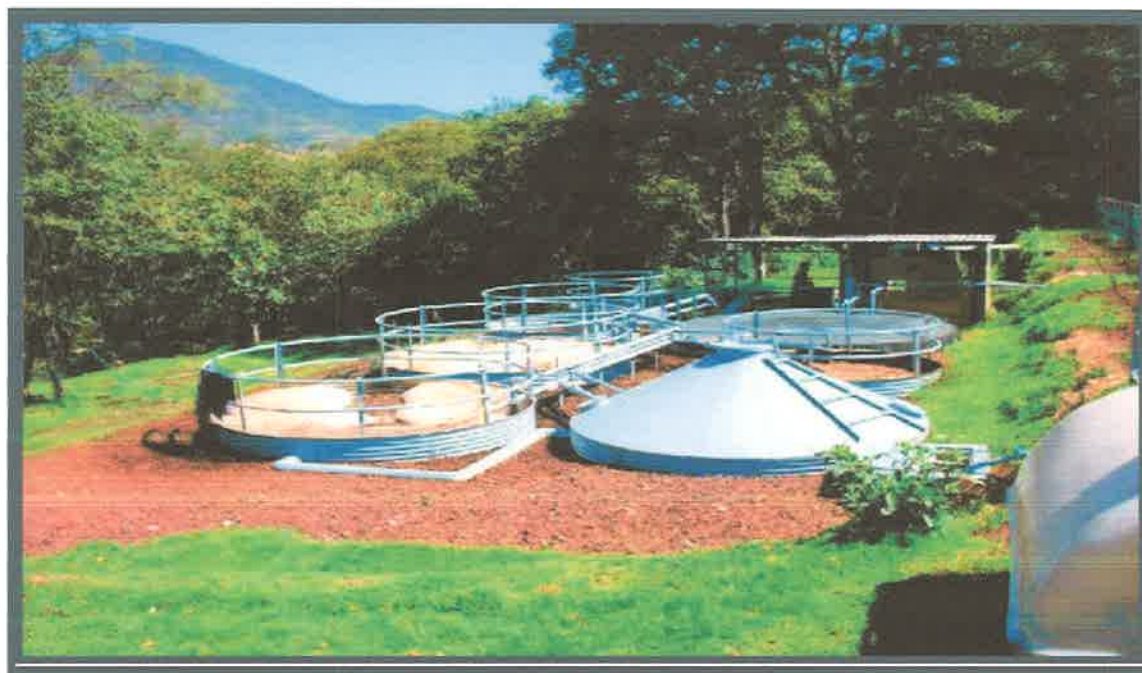
Figura N° 3. Planta de Tratamiento de Agua Residuales Enterrada
