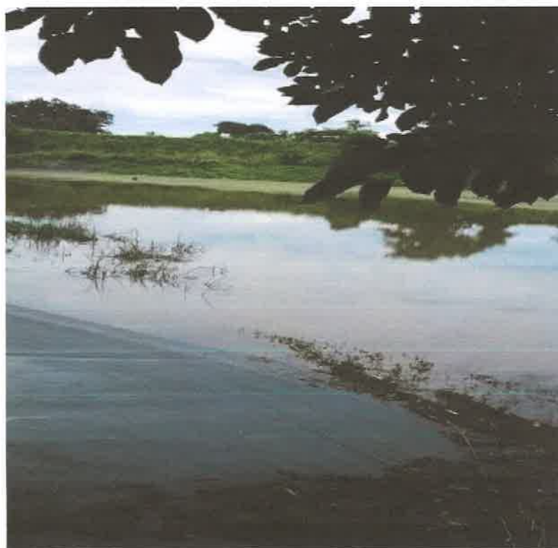
Figura 4. Vista del Lago N° 1. donde se descargarán las aguas tratadas, localizado dentro del polígono
