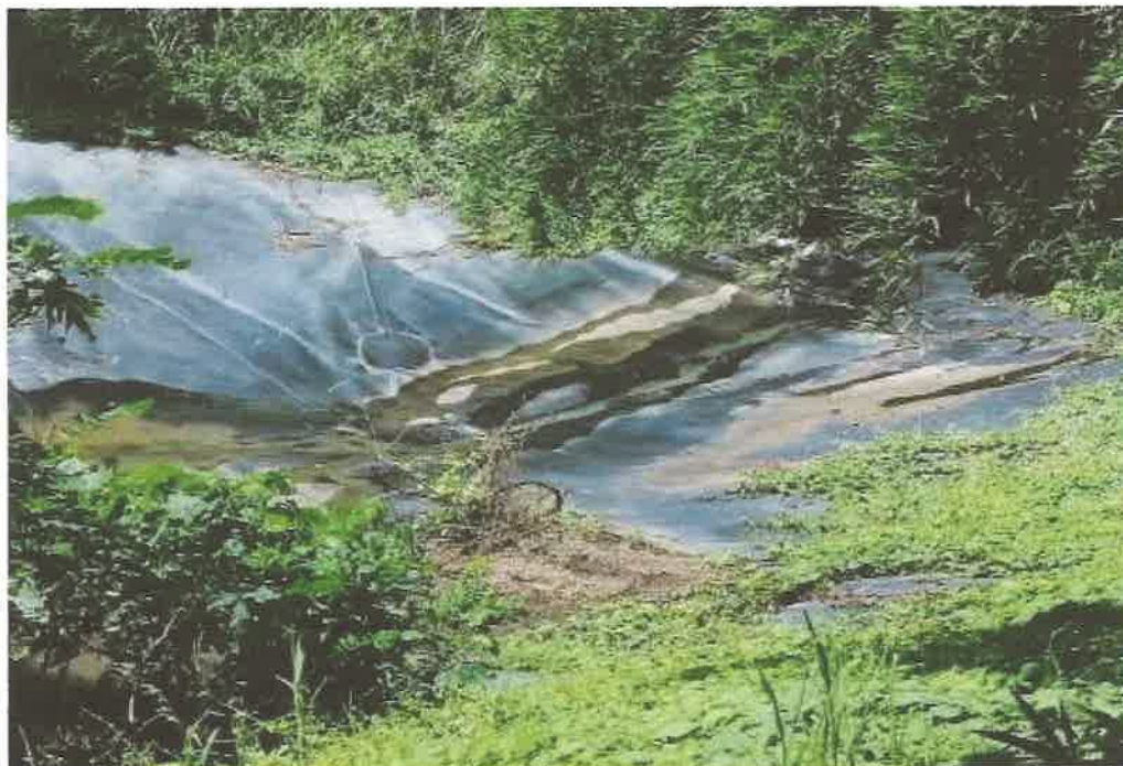
Figura 6. Descarga de aguas residuales sin tratamiento adecuado, actualmente vertidas al Lago N°1.
