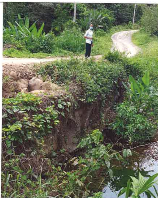
Fig. No.7 En este punto, la última crecida de la quebrada destruyó la estructura que existía. Se recomienda establecer un puente.
