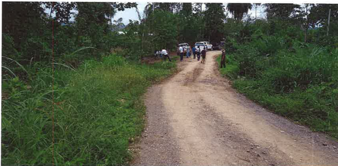
Fig. No.7 En este punto, la última crecida de la quebrada destruyó la estructura que existía. Se recomienda establecer un puente.
