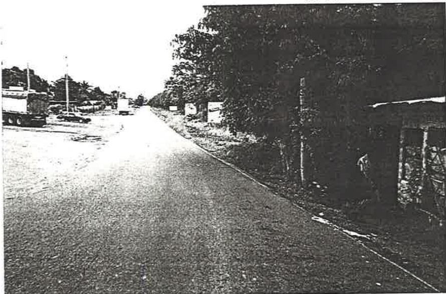
Carretera asfaltada Boquerón-Bocalatún
