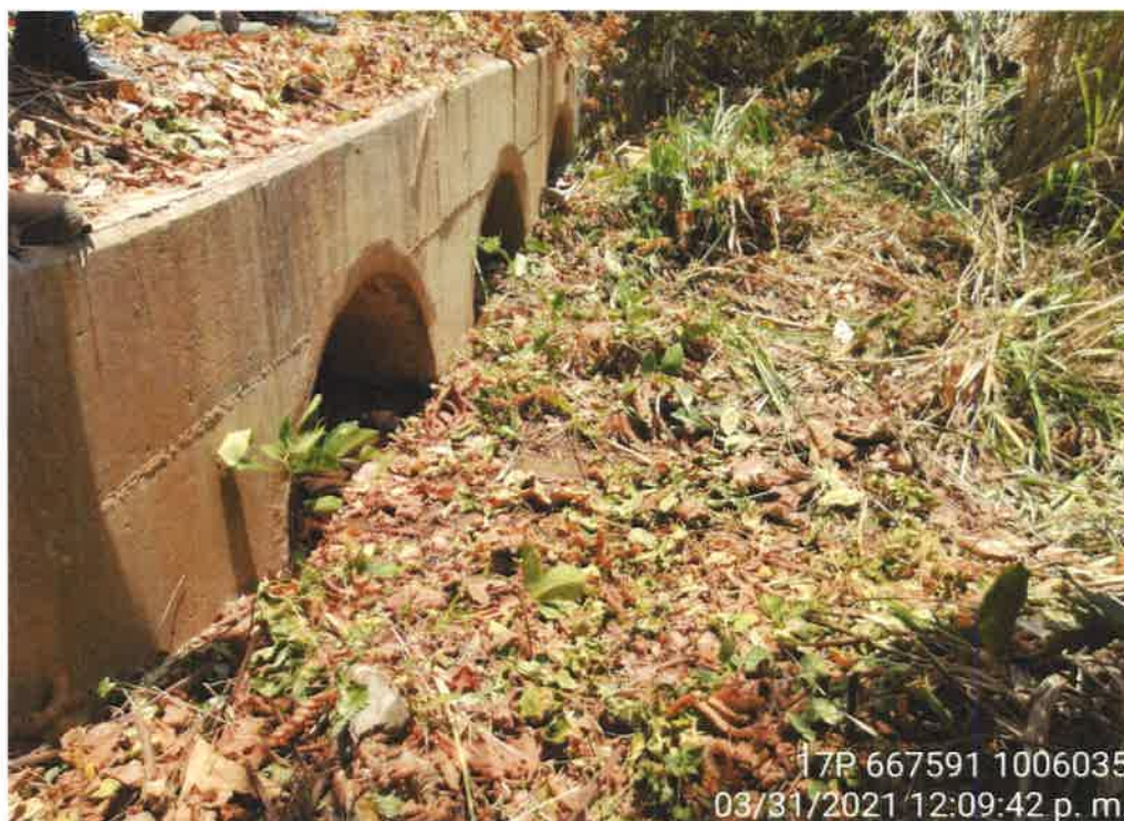
Entubado del agua pluvial proveniente de la carretera Vía Pedregal – Gonzalillo (Tres Tubos )
