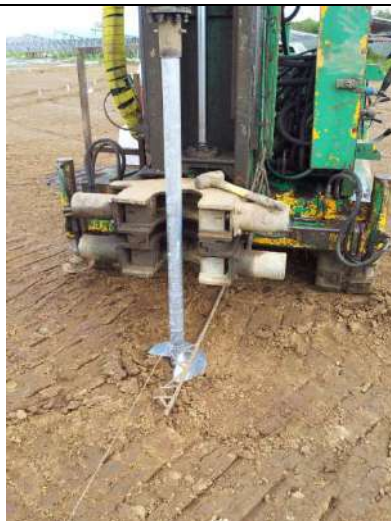
Foto 3) Perforación para el anclaje
