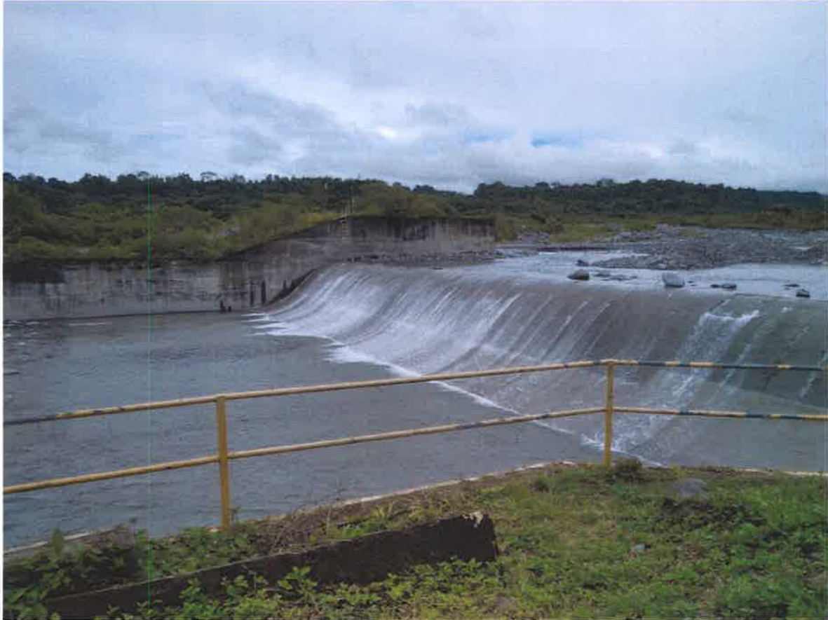
Vista general del muro de contención y dissipador de energía
