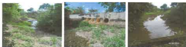
Condiciones del drenaje próximo al proyecto, sección que fue profundizada para abrebadero del ganado, riesgo de cultivos y construcción del vado existente, mayo de 2016 y septiembre de 2016 (Derecha).
