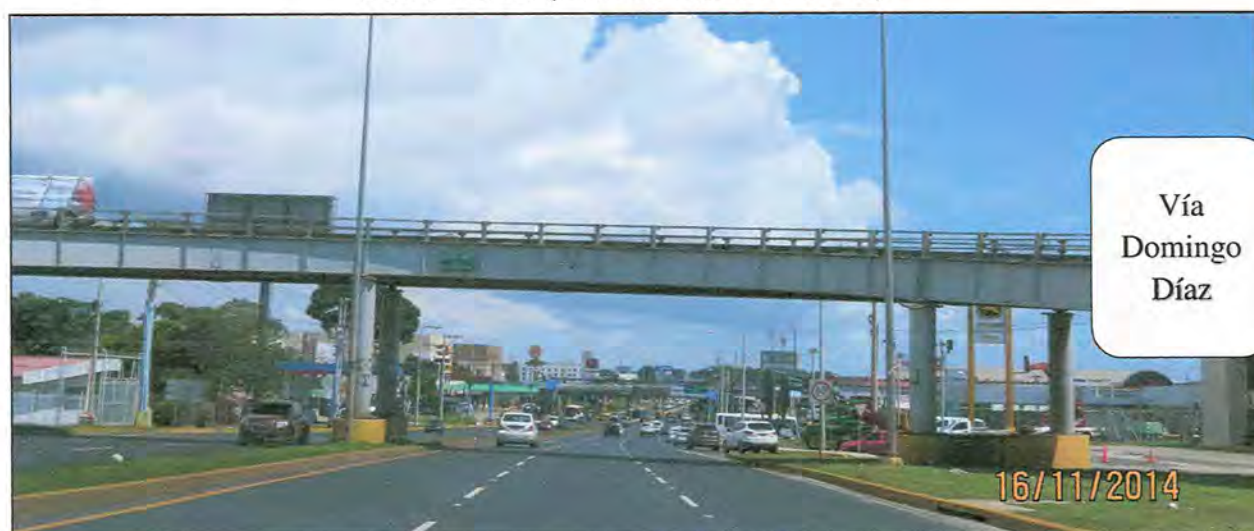
Figura 8-4. Estructuras Típicas en el Tramo entre la Estación Cincuentenario y Cerro Viento (Los Pueblos-Metromall)
