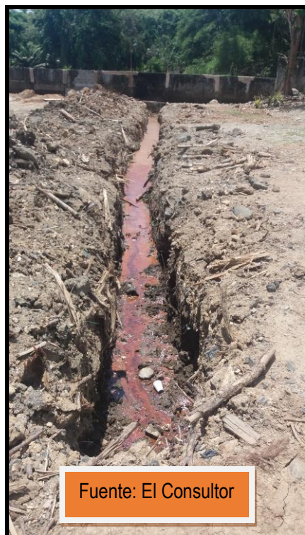
Foto No.6 Aquí se observa una enorme zanja que atraviesa la zona en estudio proveniente de aguas residuales generadas por las actividades o locales comerciales cercanos o colindantes al proyecto lo cual genera malos olores y presencia de mosquitos a la comunidad. La misma será debidamente canalizada.
