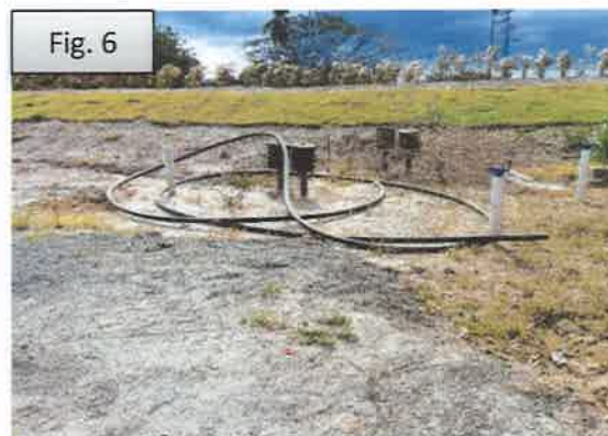
Fig. 5 y 6: Se aprecia la instalación de dos (2) tanques soterrados para el almacenamiento de 10,000 galones y sus diversos componentes. Al igual que el monolito de ventilación.
