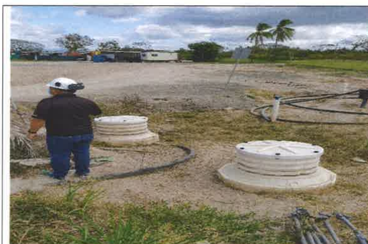
Foto No.1 Se puede observar: parte superior de los tanques soterrados, tuberías eléctricas y mangueras.
