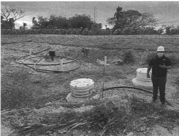
Área de tanques de combustibles ya soterrados
