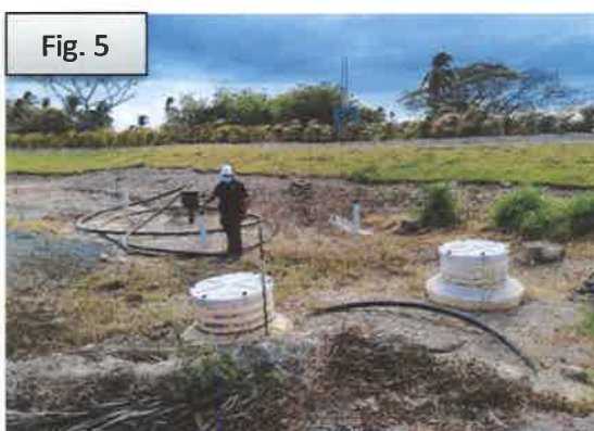
Fig. 5 y 6: Se aprecia la instalación de dos (2) tanques soterrados para el almacenamiento de 10,000 galones y sus diversos componentes. Al igual que el monolito de ventilación.
