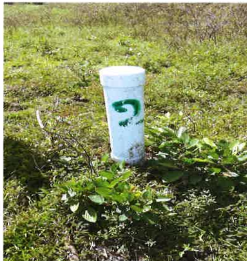
Foto 6. Vista de la ubicación georeferenciada del pozo 2, el mismo solo se encontraba con su respectivo sello sanitario.
