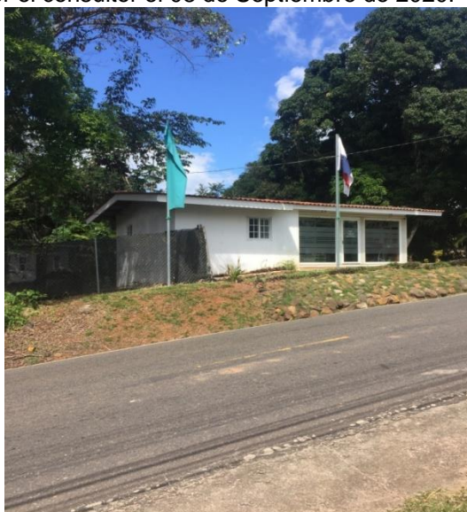
Foto No.6.2. Vista de la parte frontal del lote en la Carretera Principal de Chapala. Observar la inclinación de la vía y la Sala de Ventas de la Urbanización Ecogardens.
