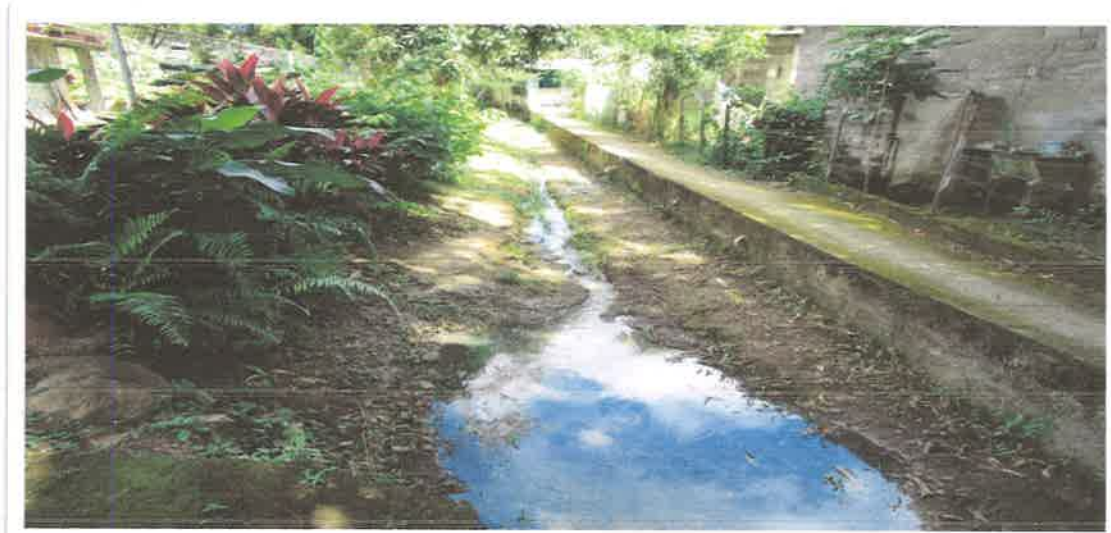
Vista de los drenajes pluviales donde se construirán los Cajones pluviales los cuales mantiene aguas producto de la descarga de aguas residuales en la comunidad de vista hermosa
