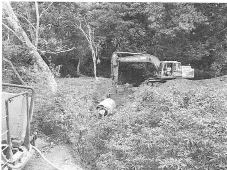
Foto#2: Construcción de badén de desvío temporal
