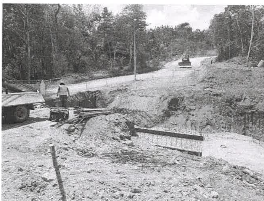
Foto#7: Vista de los trabajos de reforzamiento de acero en el Cajón Pluvial sobre Quebrada La Martillada.
