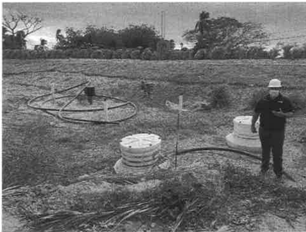
Área de tanques de combustibles ya soterrados
