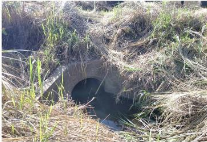
Imagen 2: Alcantarilla con Tubo de 60" Existente sobre la Quebrada.
