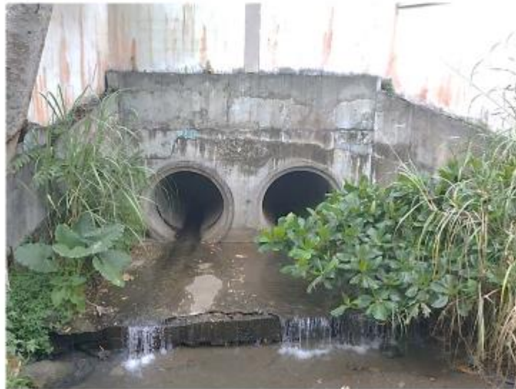
Imagen 1: Cabezal de salida de tubos en la Urb. Summer Village.
