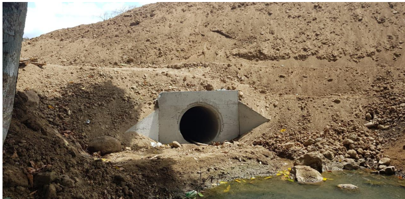
Vista del cajón pluvial construido
