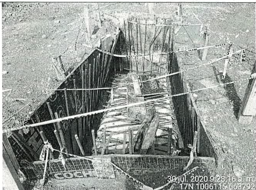
Foto 5. Observamos los cajones pluviales realizados por el promotor.
