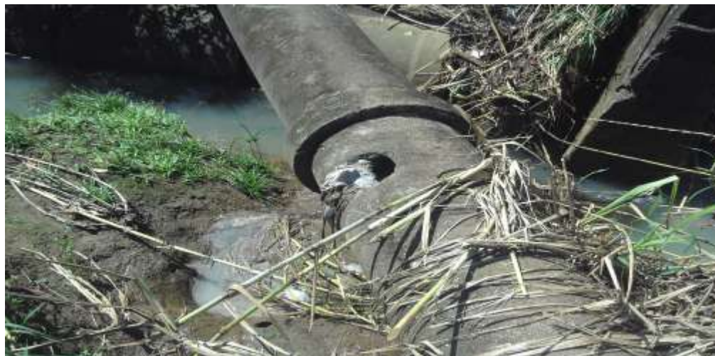
Fotografía N° 4 Tubería de la red de las Aguas Residuales rota (atraviesa el polígono es su extremo sur)
