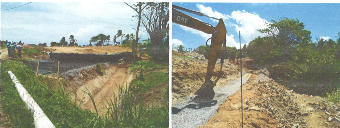
Imagen #5 y 6, se observa la línea de gaviones y pala mecánica realizando nivelación previa al colocar los gaviones.
