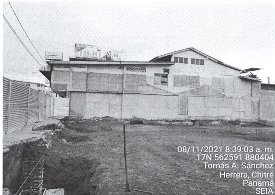
Fig. N° 2 Otra vista del área de construcción, sección que esta frente al paseo Enrique Geenzier donde se observa excavación para fundación, armado de barras de hierro al fondo
