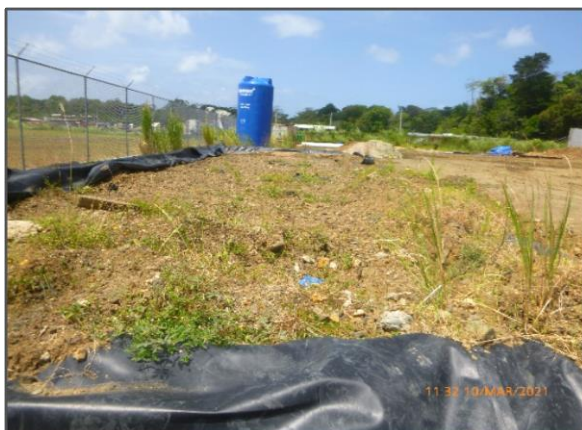
Foto 8. Vista en el sector Oeste del proyecto, sitio donde se ubicará el tanque para desechos peligrosos, área con relleno de material tosca y por debajo grava compactada. Foto 9. Vista área del sector Noreste del proyecto, colindancia de terreno con otro proyecto. Foto: A. Pérez Y.
