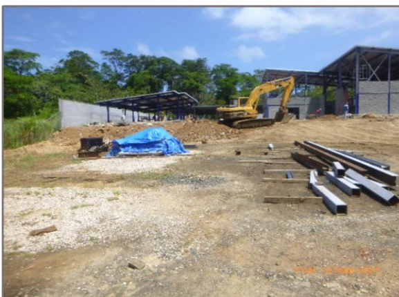
Foto 8. Vista en el sector Oeste del proyecto, sitio donde se ubicará el tanque para desechos peligrosos, área con relleno de material tosca y por debajo grava compactada. Foto 9. Vista área del sector Noreste del proyecto, colindancia de terreno con otro proyecto. Foto: A. Pérez Y.
