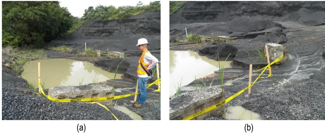
Foto 7. Piscina sedimentadora del agua proveniente del PIT.
