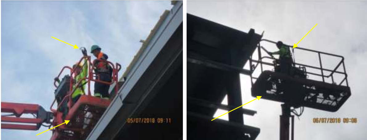
Imágenes 19 y 20. Vista de elevador hidráulico y el uso del arnés
