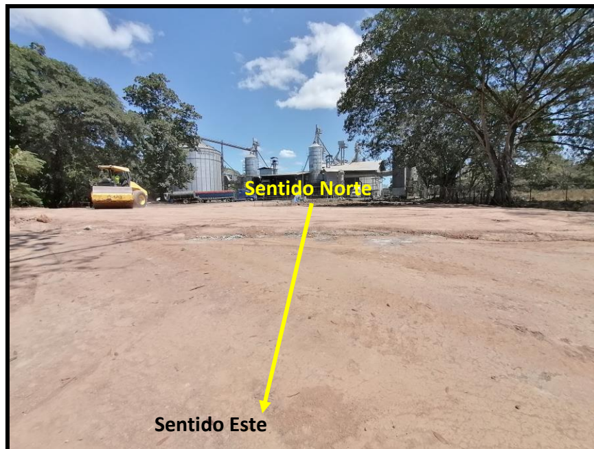
Figura 21. Pendiente del 2% en sentido Norte-Sur en el terreno del proyecto
