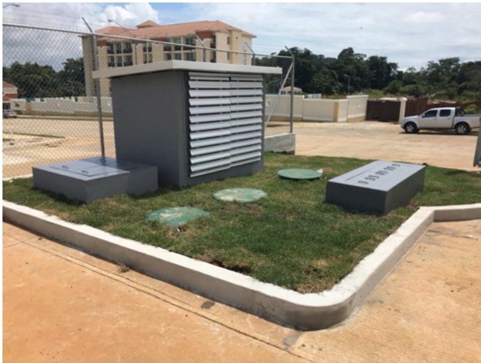
Sistema de Tratamiento de Aguas Residuales Compacto.
