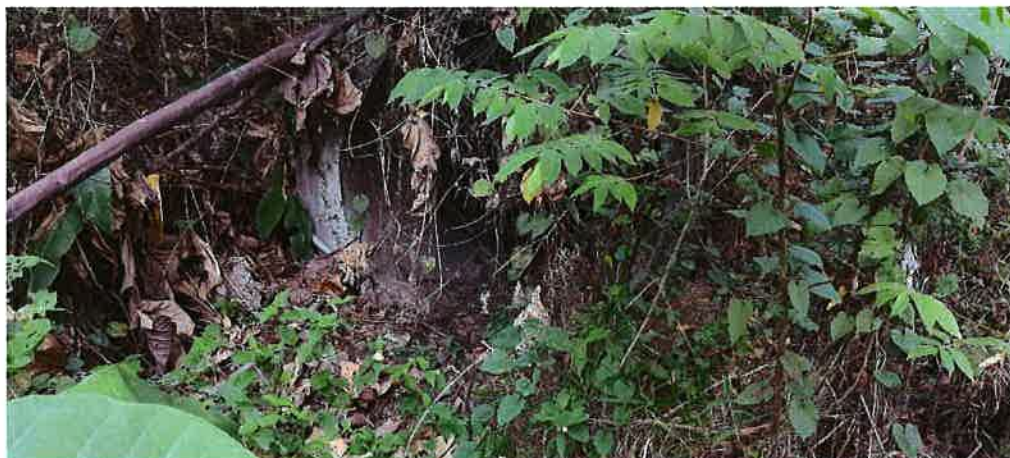
Tubería por drena el agua del estanque
