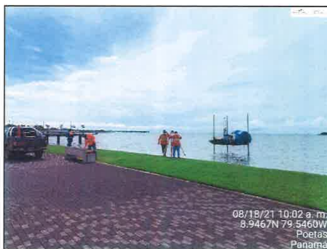
Foto N°5. Trabajos de topografía y estudios de suelo
