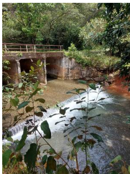
P7 Quebrada de tamaño medio con puente y cruce de cajones
