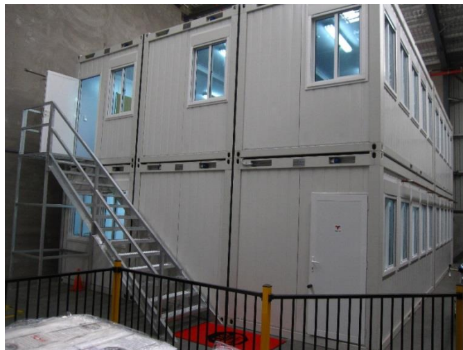
Ilustración 1 Prototipo de un sistema de construcción modular. Fuente: Cocinas del Canal S.A., 2020
