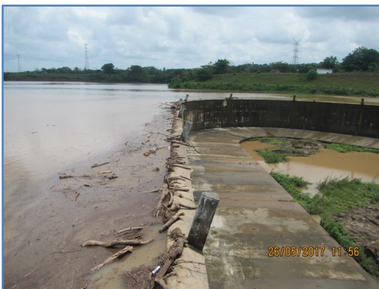
Figura N° 4. Vista del Vertedero Libre de la Presa El Corro.
