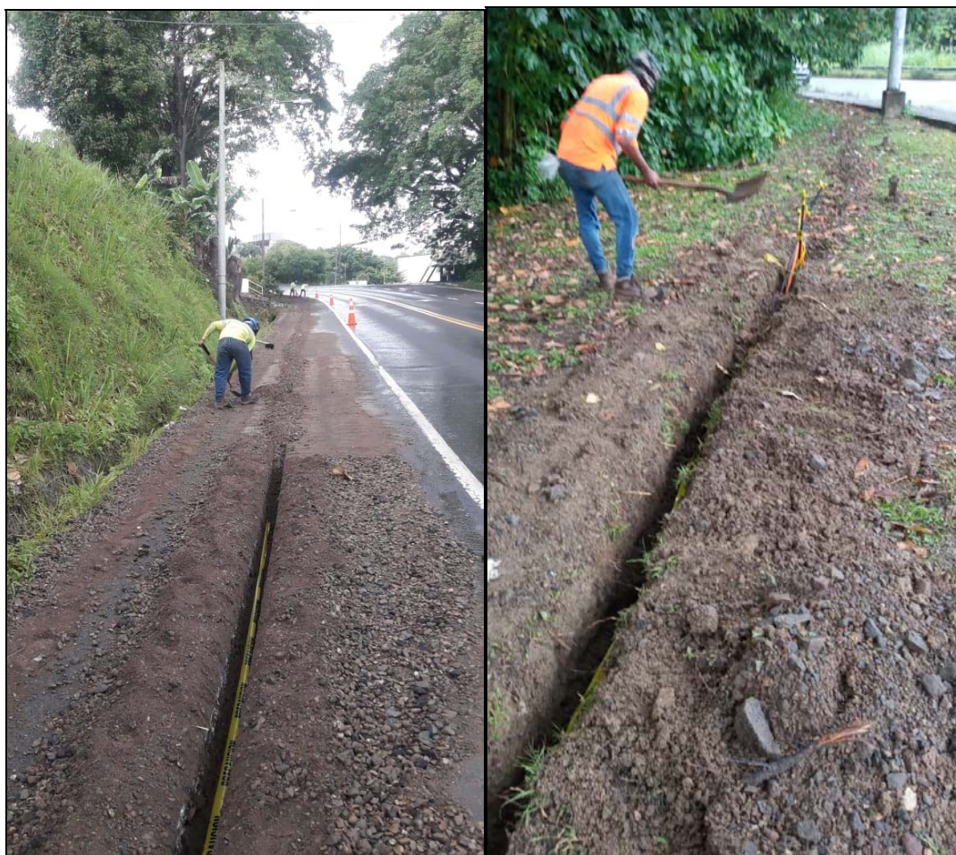
Figura 5: Ejemplo de la actividad de zanjado
