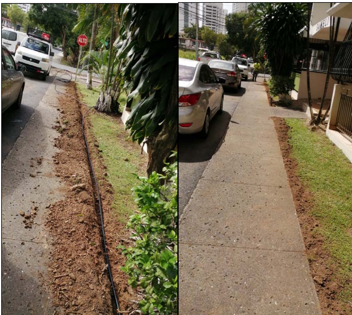
Figura 6: Llenado del espacio con tierra de la excavación
