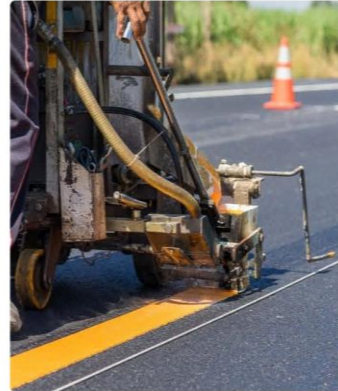
Aplicación de pintura termoplástica
