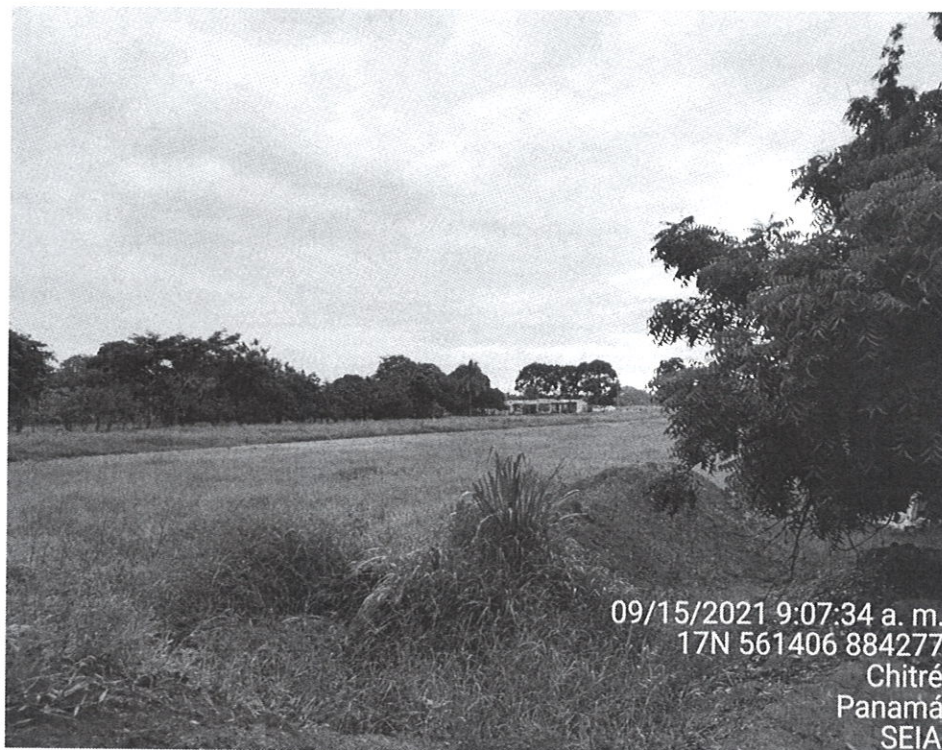
Fig. N° 3 Se observa material excedente del corte de la calle, según se nos indicó en la inspección, el mismo será colocado en las partes más bajas del terreno como relleno.
