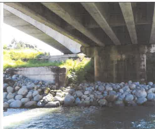
Foto 5. Vista de la base del puente a demoler y las piedras acumuladas para protección.
