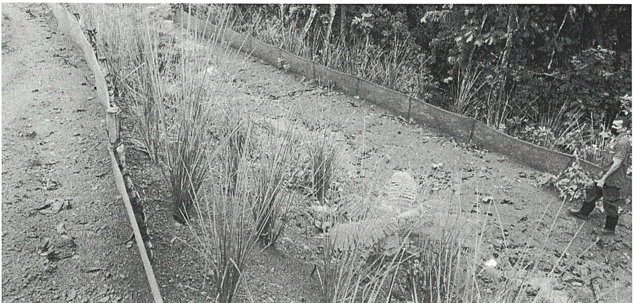
Imagen N° 7, 8, 9: establecimiento de barreras muertas y vivas para estabilizar los taludes y minimizar la erosión y arrastre de sedimentos al cuerpo hídrico denominado quebrada Sin Nombre Foto Tomada por: Jean C. Peñaloza; Fecha: 19/08/2021
