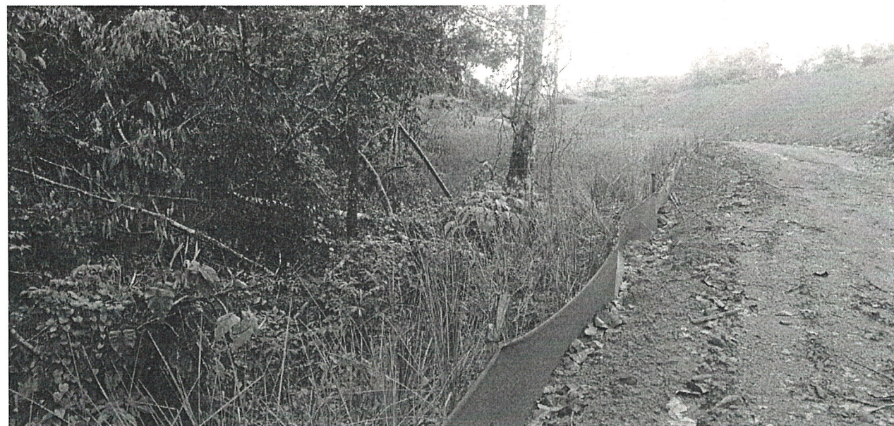
Imagen N° 10, 11, 12: otras visuales panorámicas del establecimiento de medidas de compensación y mitigación sobre el alineamiento de la línea sanitaria, a fin de disminuir la suceptibilidad de erosión y arrastre de sedimento de suelo, sobre el cauce hídrico. Foto Tomada por: Jean C. Peñaloza. Fecha: 19/08/2021
