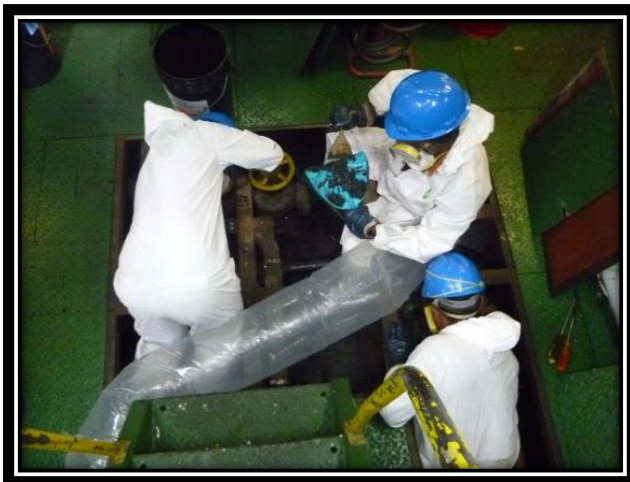
Instalación de sistema de ventilación y desgasificación de tanques de hidrocarburos
