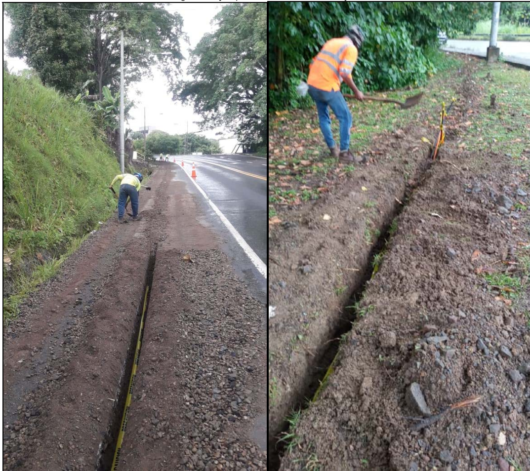
Figura 5: Ejemplo de la actividad de zanjado
