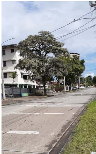
Vistas fotográficas 9 a 11: Vistas del frente del área del proyecto
