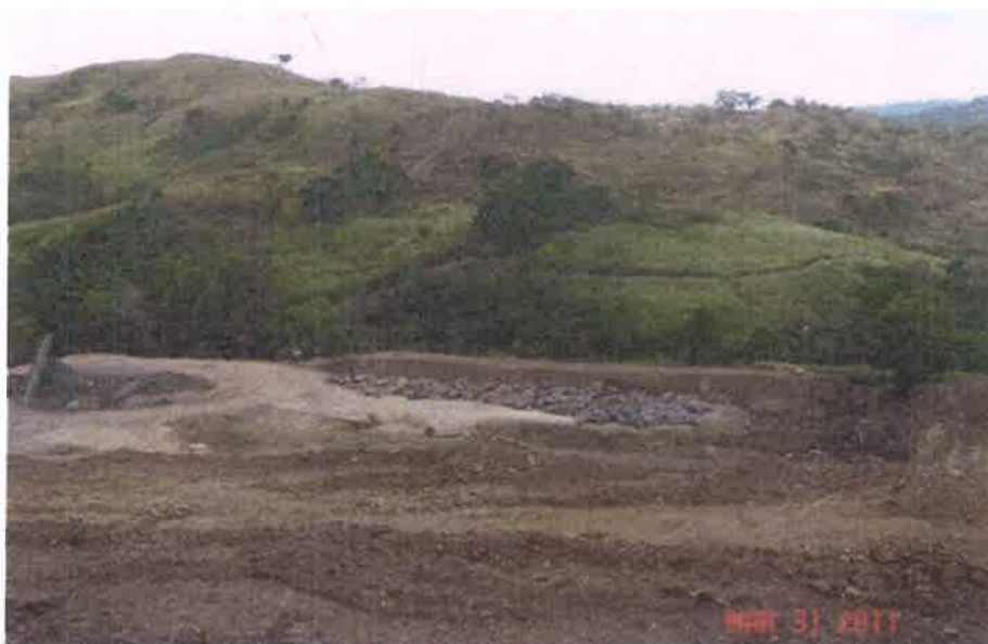
Fotografía 3 Imagen tomada en marzo 2011 se observa la realización de actividades de acumulación de material rocosa, cambio en topografía debajo de la servidumbre eléctrica. Actividad no permitida por seguridad de la línea de transmisión.
