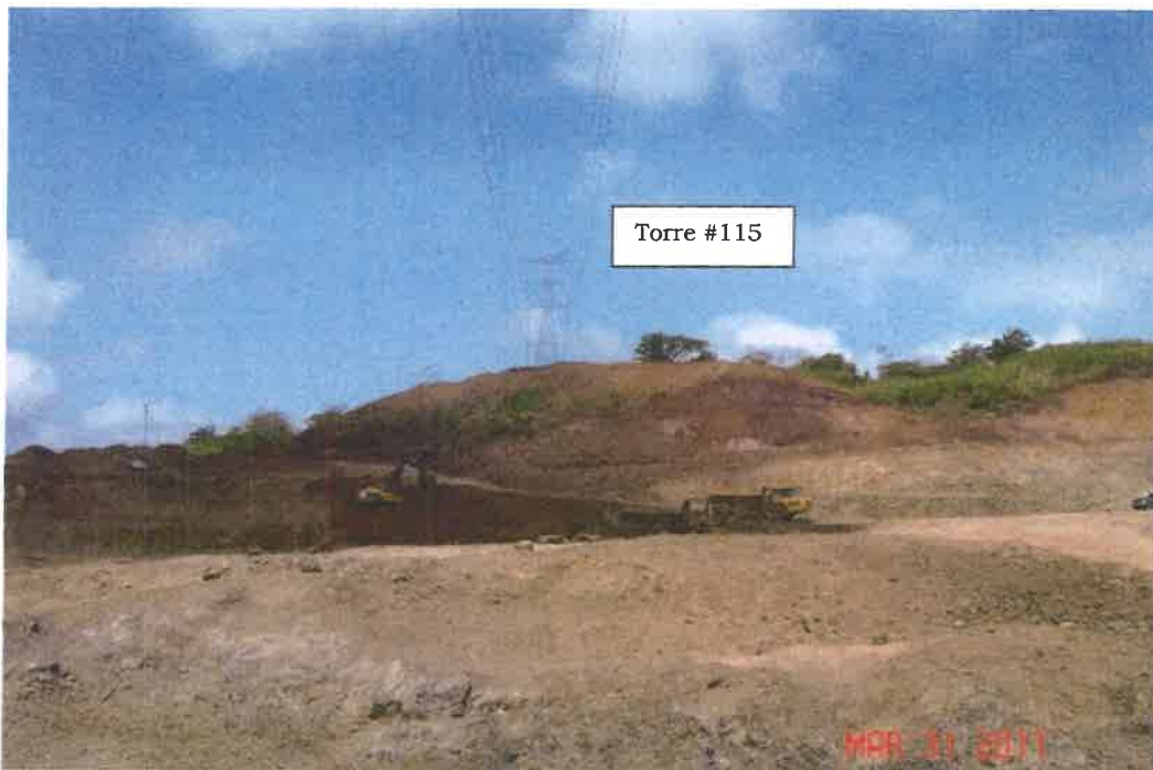
Fotografía 5 Imagen tomada en marzo 2011 en donde se observa movimiento de camiones de equipo pesado debajo de la servidumbre eléctrica. Actividad no segura.
