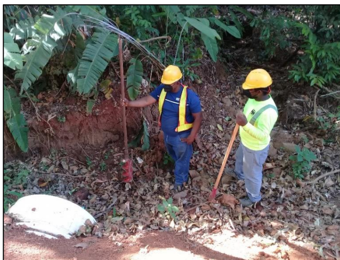
Figura 12. Trabajos con barreno manual para verificar influencia de fosa con agua. Fuente: Equipo Consultor, 2021.
