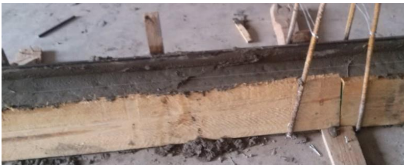
Ejemplo de encofrado y vaciado de brocal perimetral al área de lavado.
