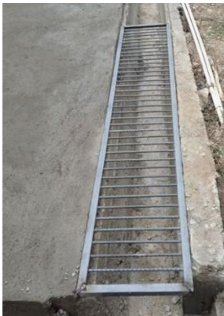
Canaleta con rejillas para captar y conducir las aguas de lavado.
